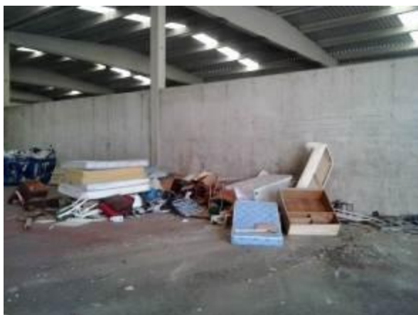
Almacenamiento de residuos voluminosos.
